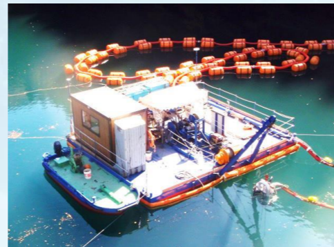
※浚渫工（浚渫作業台船運転）
