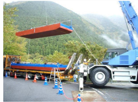
※浚渫作業台船組立および排砂管
