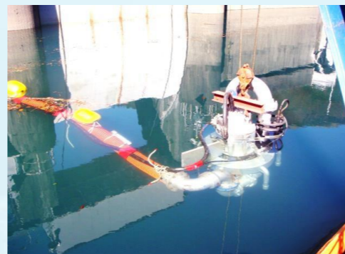
※貯泥ピット配土および脱水処理
