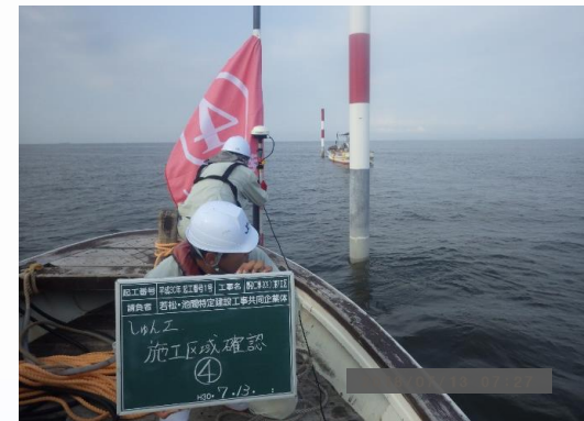
施工区域確認
